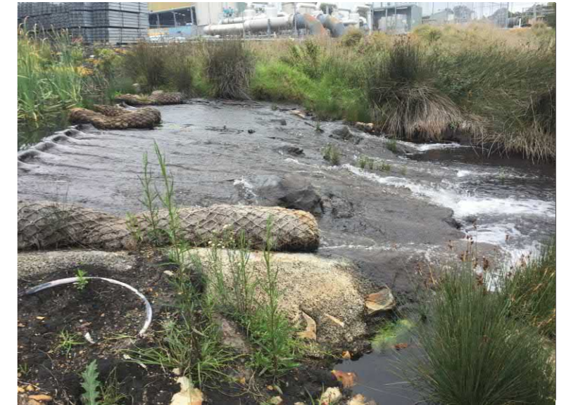
M4 Spillway NW corner
